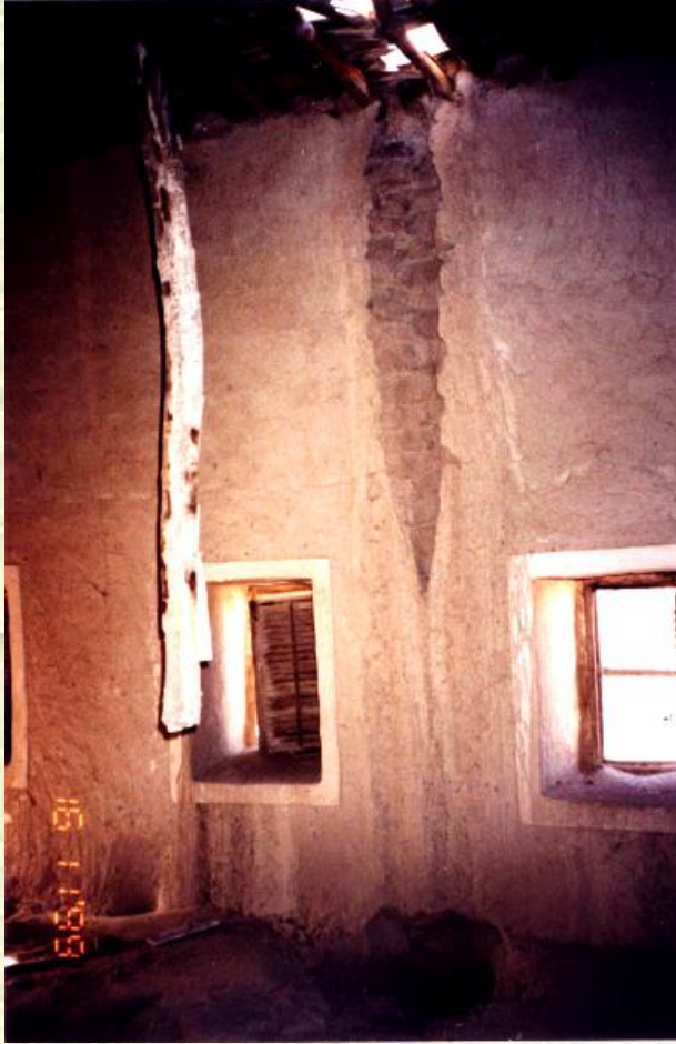
تدهور بالسقف وكذلك بالحائط والأرضية نتيجة لتسرب الأمطار
