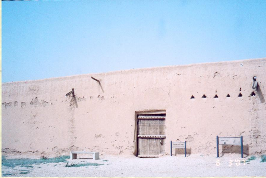
قصر ناصر: الواجهة الشرقية تآكل بسبب تسرب مياه الأمطار من خلال السقف والمياه الأرضية
