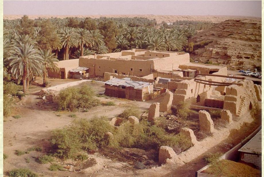
الموقع أثناء الترميم
