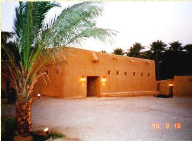
الجناح الجنوبي بعد الترميم
