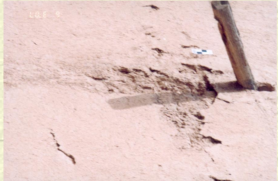
قصر ناصر: الواجهة الشرقية تآكل بسبب تسرب مياه الأمطار من خلال السقف والمياه الأرضية
